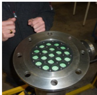
Mise en place du joint galette d'étanchéité
